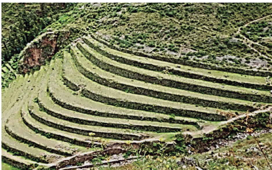
Foto 9. Andenes en Pisac, Cusco perfectamente contruidos Actualmente no son utilizados por la falta de agua, que fue destinada, para uso de la población urbana.
